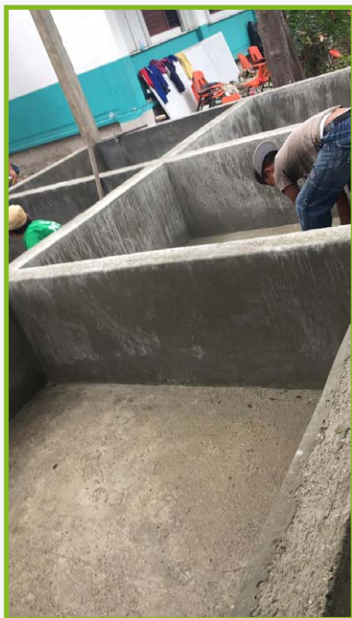
Proceso de construcción de compostero
